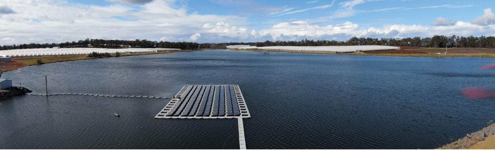
Corindi solar array
